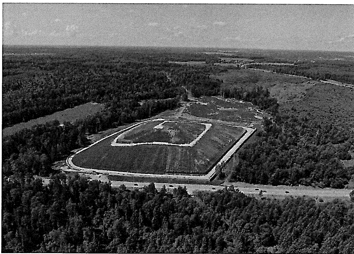
Рисунок 16. Полигон ТКО «Аннино» после рекультивации
