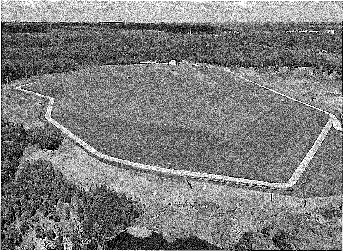
Рисунок 23. Полигон ТКО «Парфеново» после рекультивации
