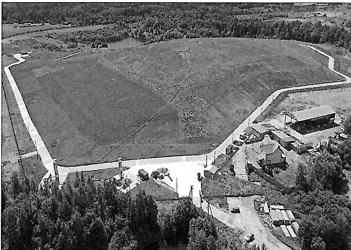
Рисунок 25. Полигон ТКО «Часцы» после рекультивации
