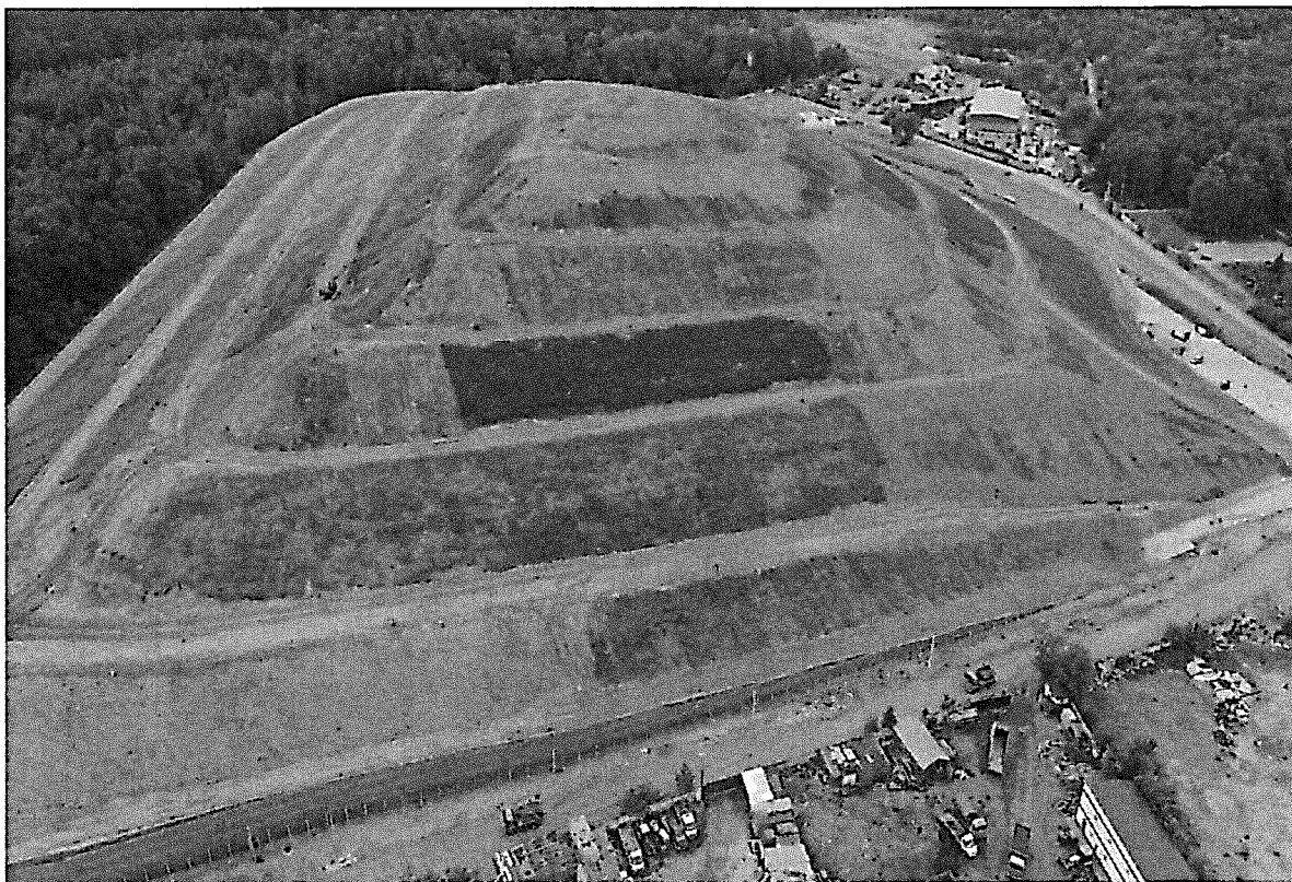
Рисунок 13. Полигон ТКО «Долгопрудный» после рекультивации
